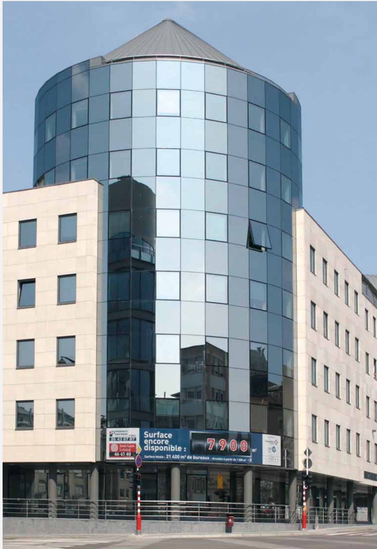
Espace Pétrusse-Le Dôme, staden Luxemburg
