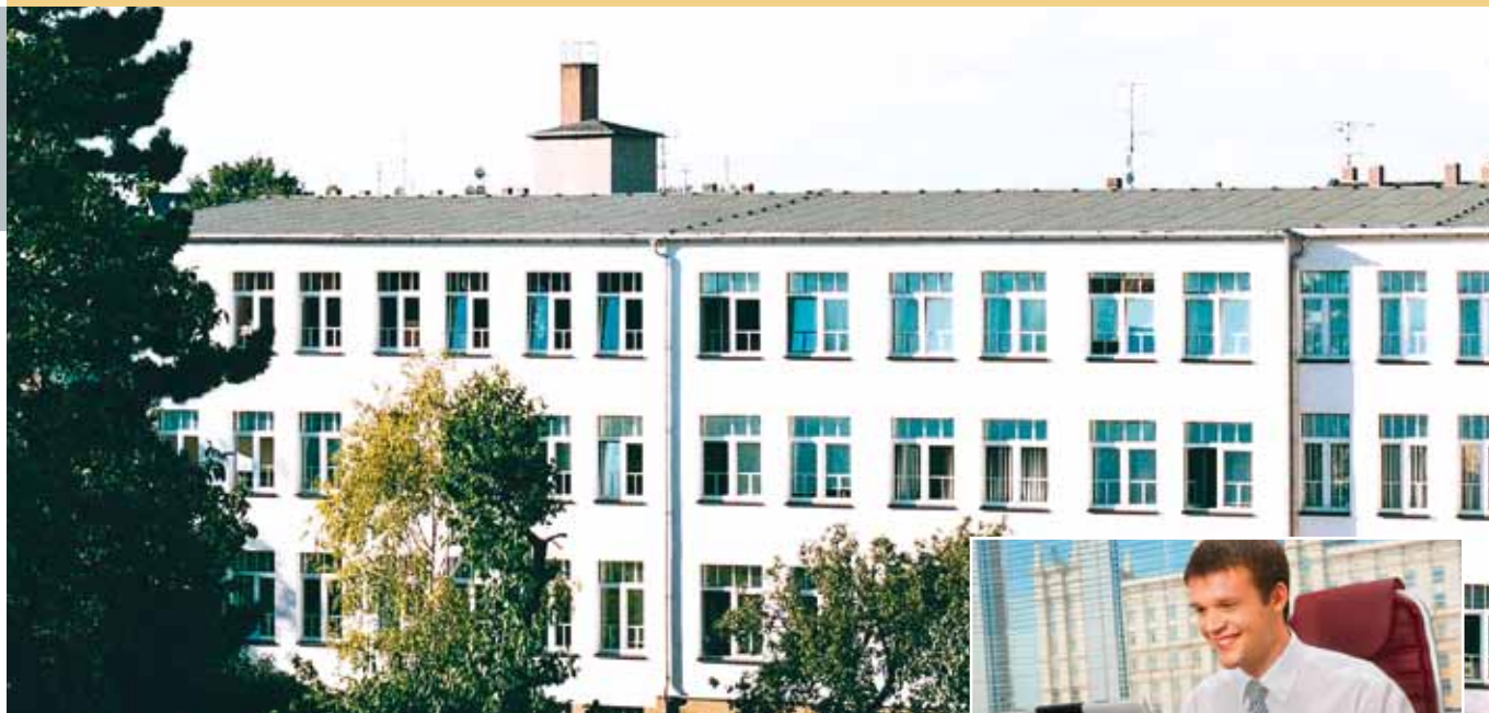
Produktionsbyggnaden vid MULTIFILM Sonnen- und Blendschutz GmbH
